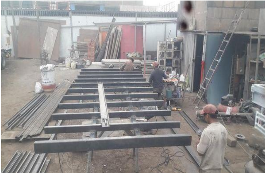
Figura N° 3. Área de Corte y Soldadura
