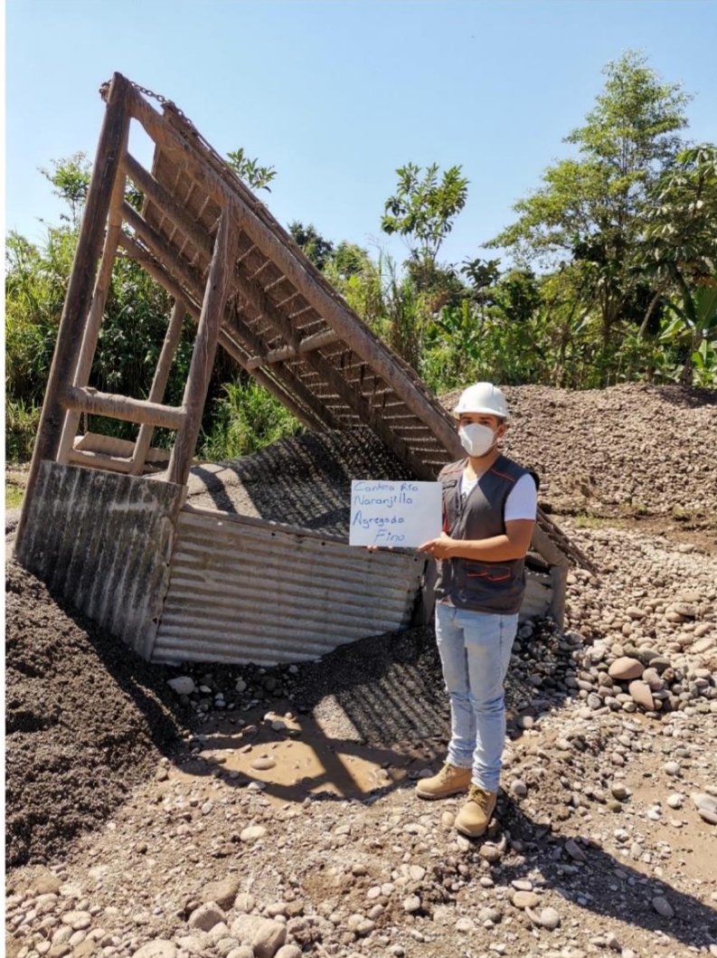
Fotografía N° 02 y 03. Extracción del material
