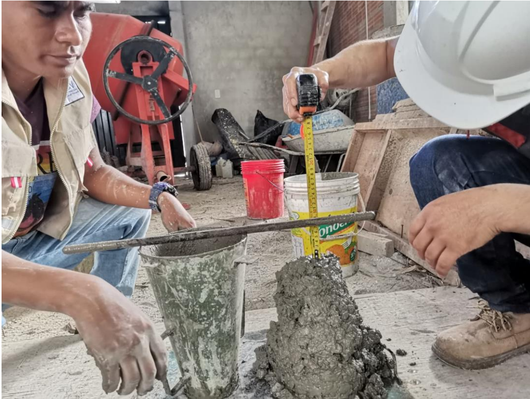
Figura 18 Ensayo de Slump, 3"- Fuente Propia.
