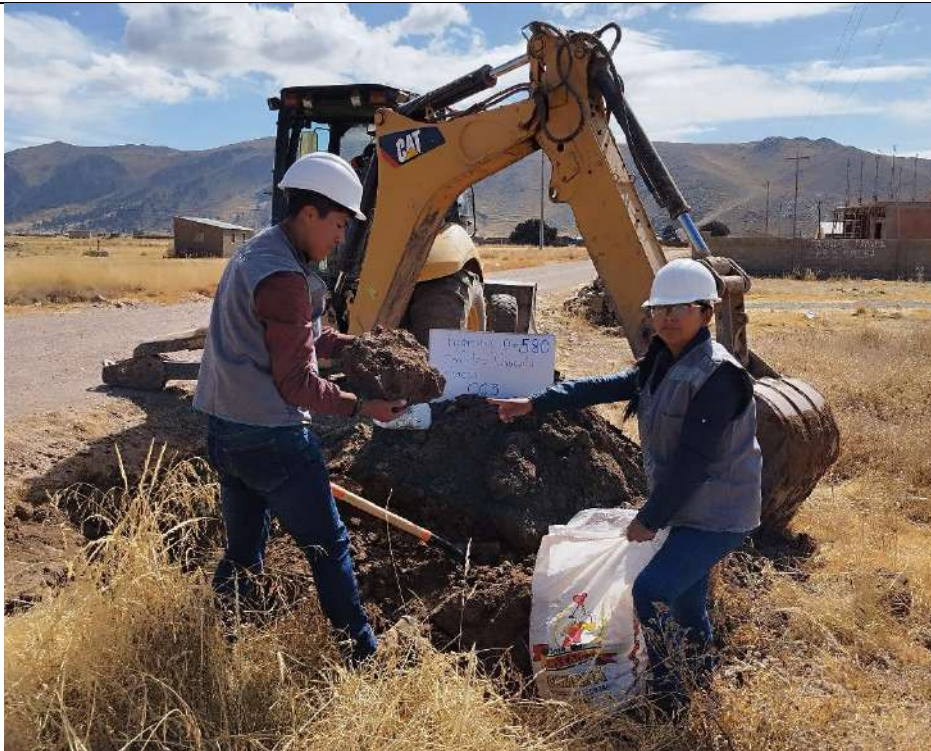
FOTO N°01: Extracción de muestras de la calicata N° 03, progresiva 0+580
