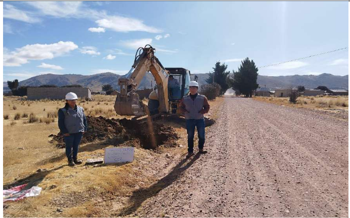
FOTO N°03: se realiza la calicata N° 03, progresiva 0+320
