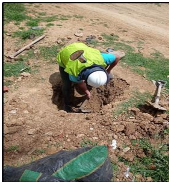
Figura 6: Limpieza de los materiales orgánicos e inicio de excavación del humus, según referencia de la norma MTC E 101. FUENTE: Elaboración propia
