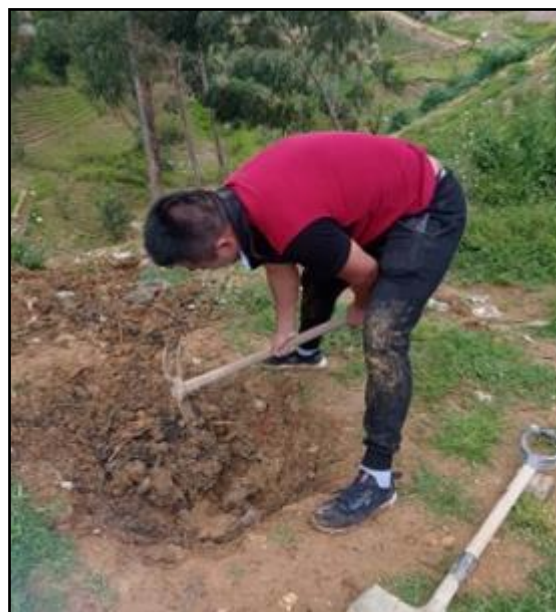
Figura 2: Limpieza de los materiales orgánicos e inicio de excavación del humus, según referencia de la norma MTC E 101. FUENTE: Elaboración propia
