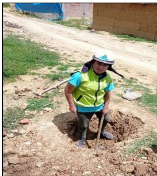
Figura 10: Limpieza de los materiales orgánicos e inicio de excavación del humus, según referencia de la norma MTC E 101. FUENTE: Elaboración propia
