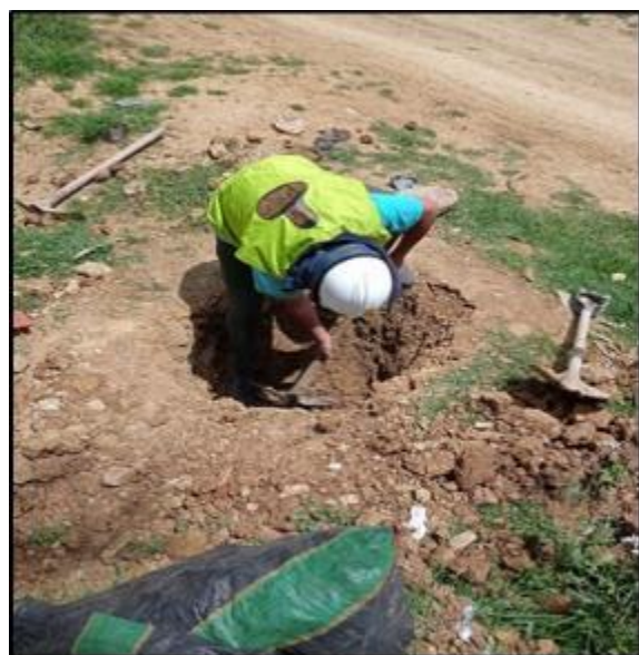
Figura 8: Finalización de la excavación de la calicata y evidencias, según referencia de la norma MTC E 101. FUENTE: Elaboración propia
