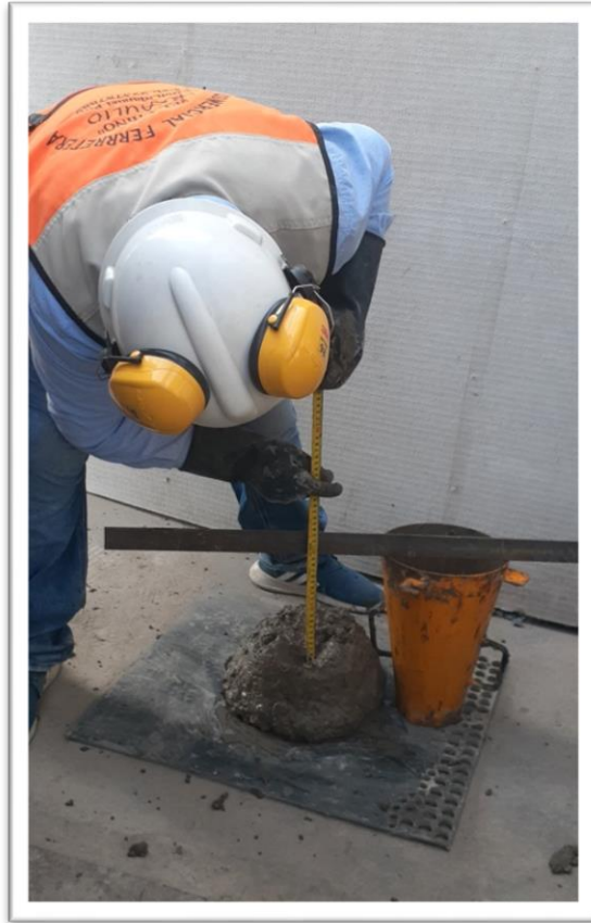
Fotografía 28: midiendo el revenimiento del concreto
