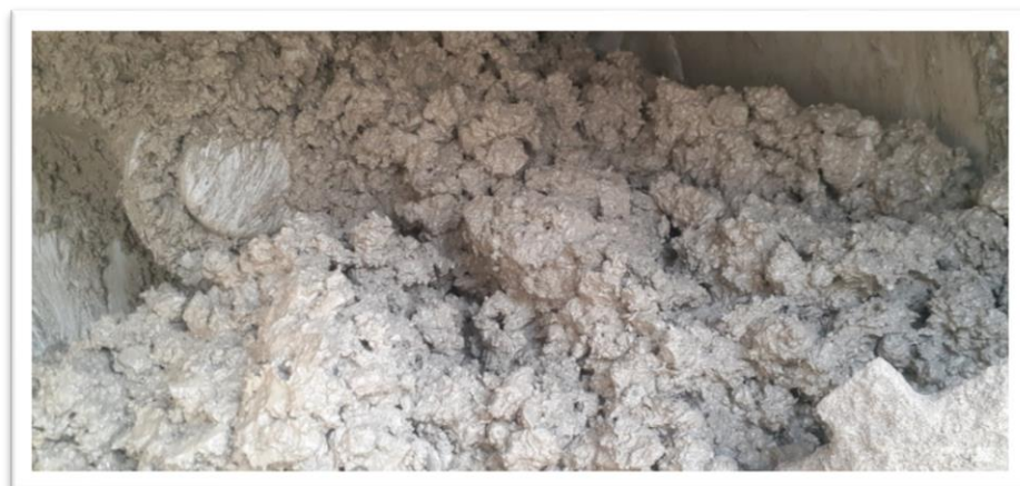
Fotografía 18: consistencia de la mezcla sin alterar el agua requerida
