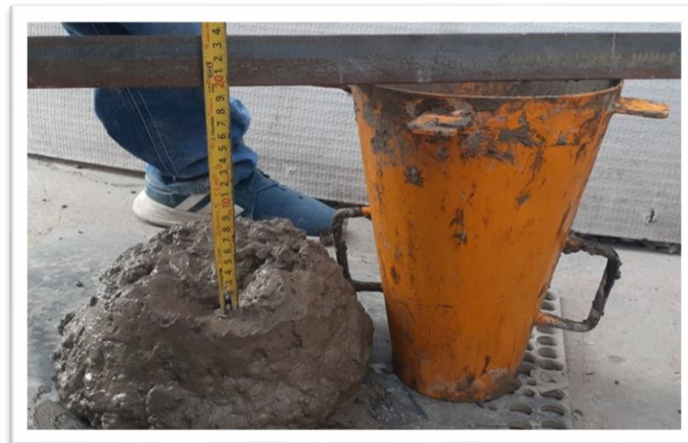
Fotografía 29: midiendo el revenimiento del concreto
