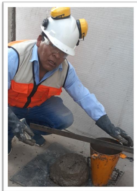
Fotografía 27: ensayo de revenimiento
