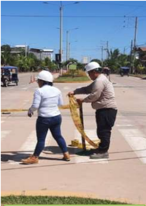
FOTOGRAFIA 07: Se puede observar, la colocación de señalización para nuestra seguridad.
