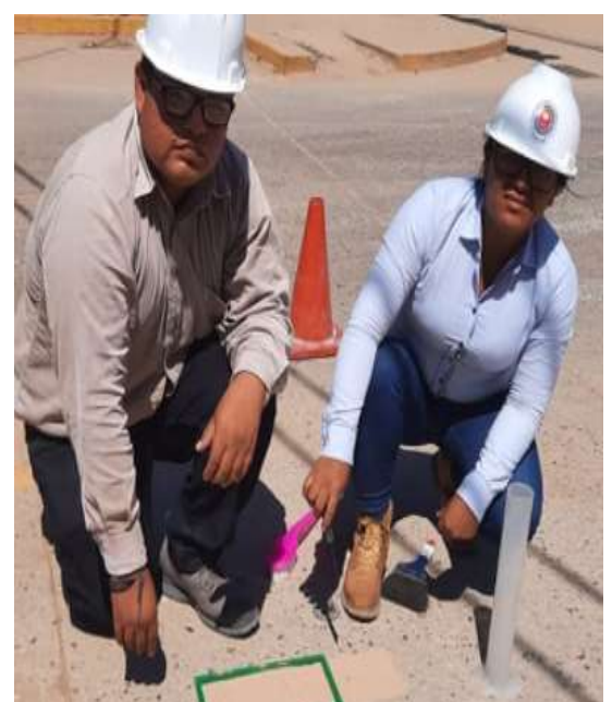
FOTOGRAFIA 12: Se puede observar, la arena ya regada y esparcida en el pavimento
