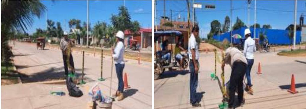
Figura 7. Colocación de las señalizaciones para un mejor trabajo.
