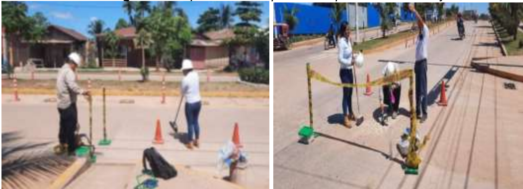
Figura 8. Limpieza de la superficie de pavimento a trabajar.
