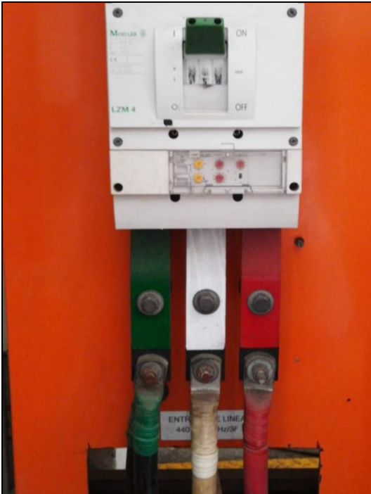
Interruptor principal del Tablero de banco N°02
