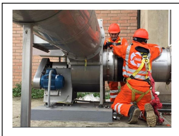
Figura N° 10: Montaje de sistema de inyección y extracción.
