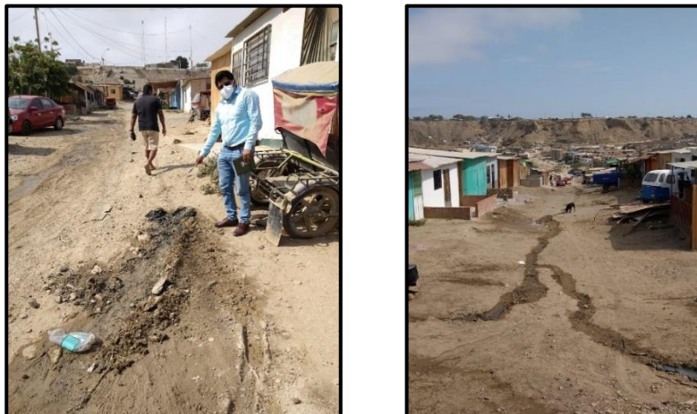
Imagen N° 12: Colapsos de silos en el A.H. Sol de Oro
