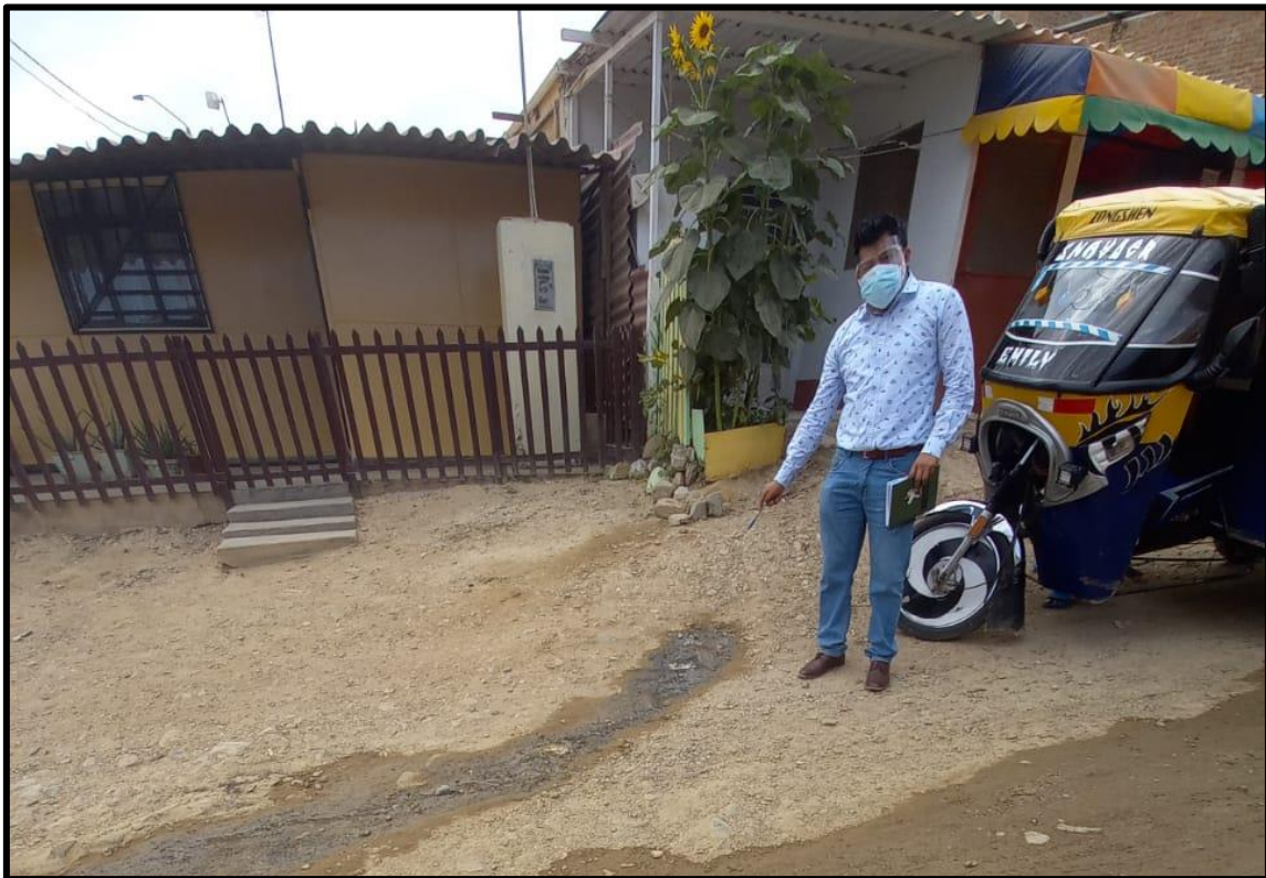
Imagen N° 47: Afloramiento de aguas residuales de silos
