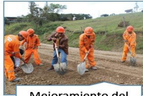
Mejoramiento del acceso al Mirador
