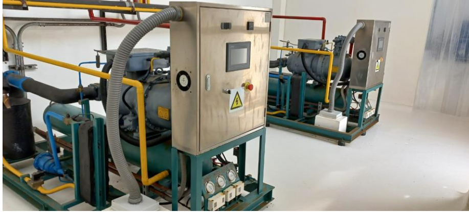
COMPRESORES DE TORNILLO
