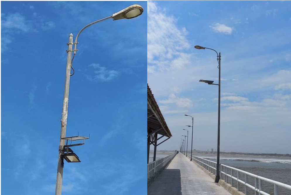
Figura 27 Implementación de la optimización tecnológica en el muelle y plataforma del muelle usando luminarias LED SOLAR.
