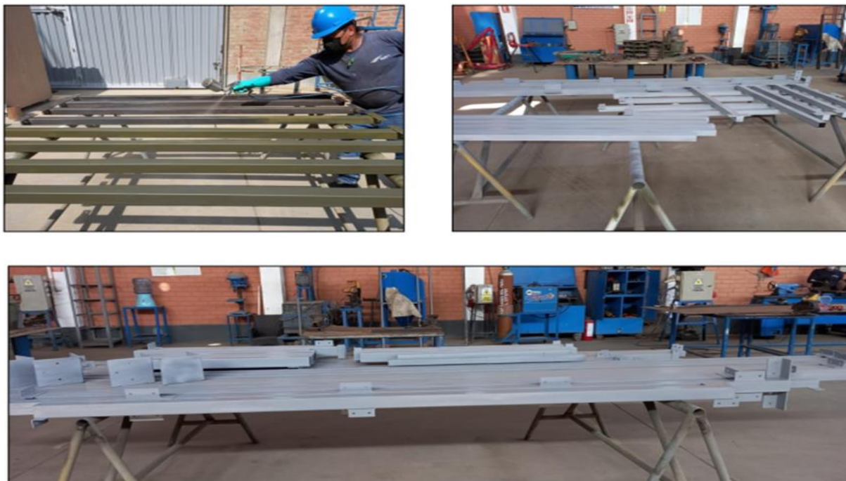
Figura 13: Proceso de fabricación de estructuras
