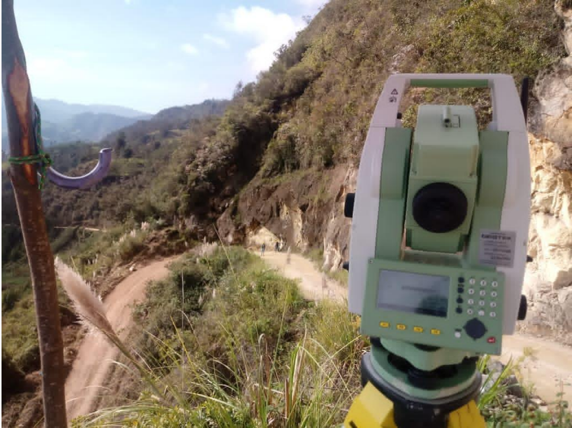
Foto 3: Estación total utilizada para el levantamiento topográfico.
