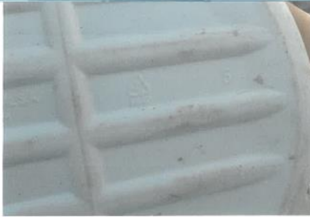
Foto N° 03 Verificación del PEAD tipo 2.
