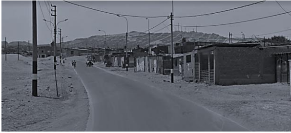
Figura N°26: Av. Santa Rosa
