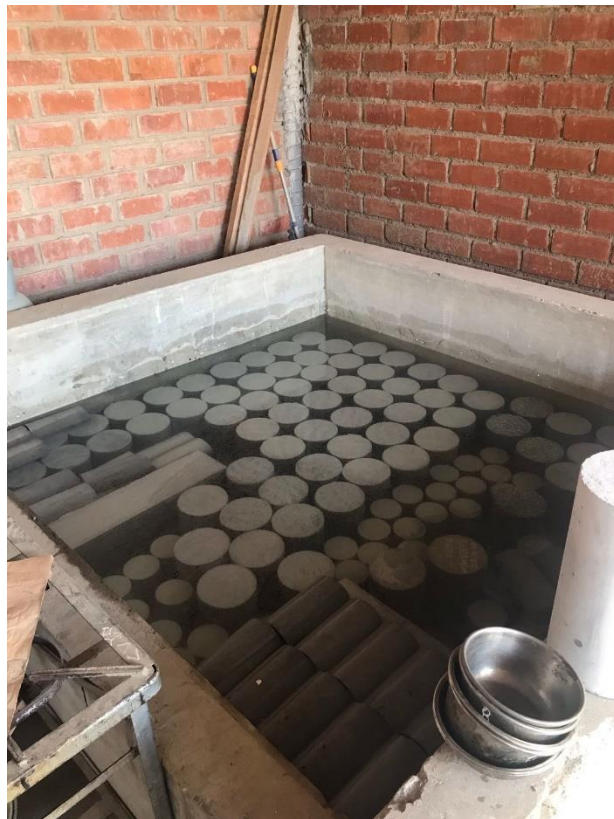
Curado del concreto
