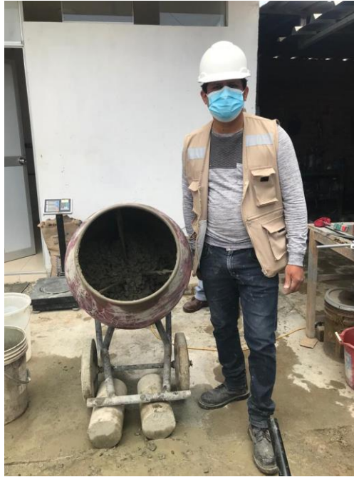
Figura 28. Concreto en mezclador eléctrico Fuente: Elaboración propia
