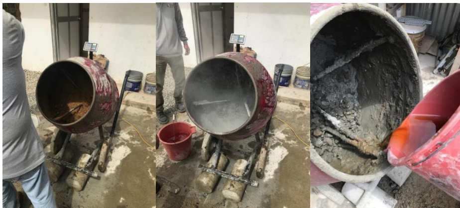
Figura 27. Mezclado del concreto segun procedimiento Fuente: Elaboracion propia
