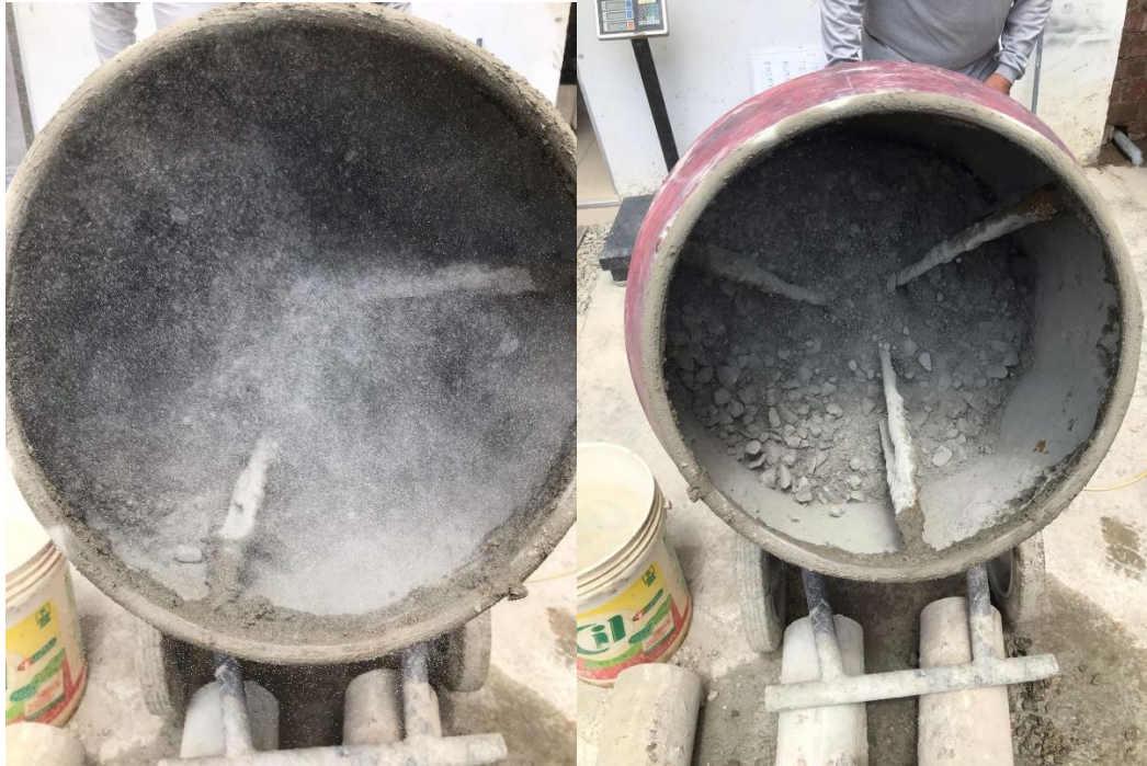
Mezclado en seco de los componentes del concreto
