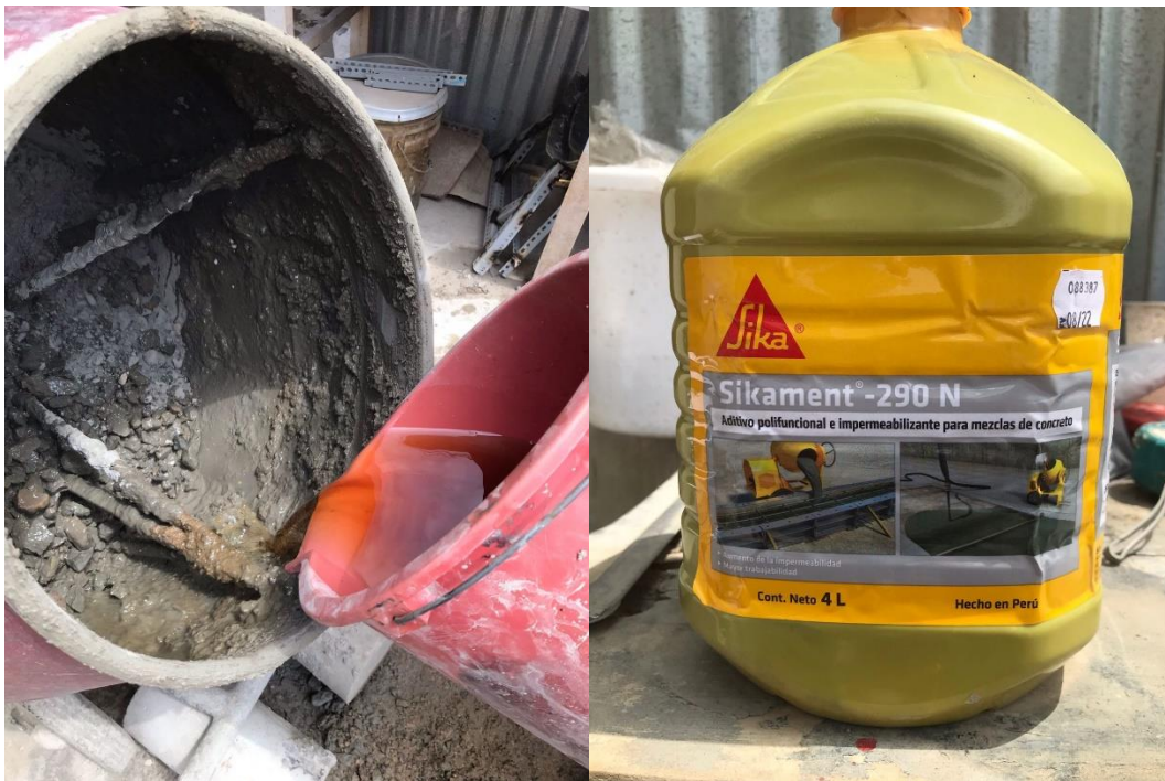
Incorporación de agua y aditivo a la mezcla de concreto
