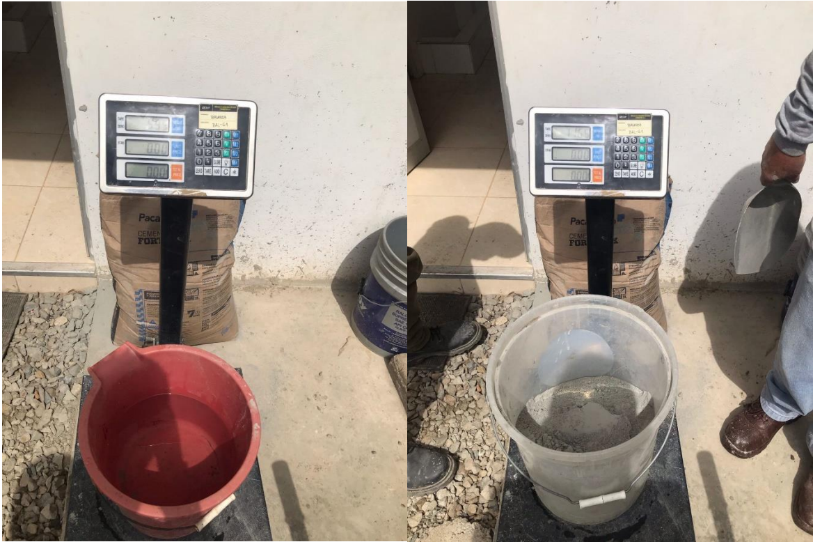
Pesaje del cemento y agua para el mezclado
