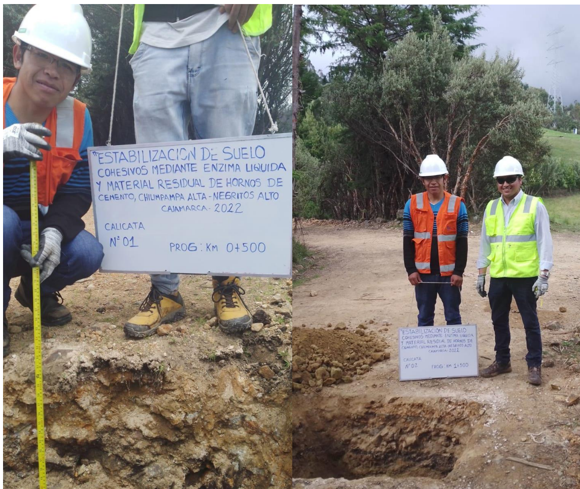
Imágenes de la calicata N° 1
