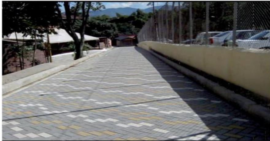
Figura 6: Colocación de las hileras de los adoquines
