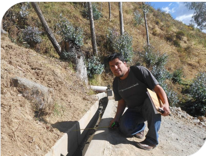
Fotografía N° 01: En la presente vista fotográfica se observa las mediciones de la sección del canal
