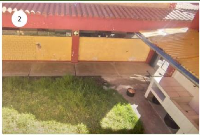
2. TECHOS DE TEJA Y VENTANAS DE FIERRO
