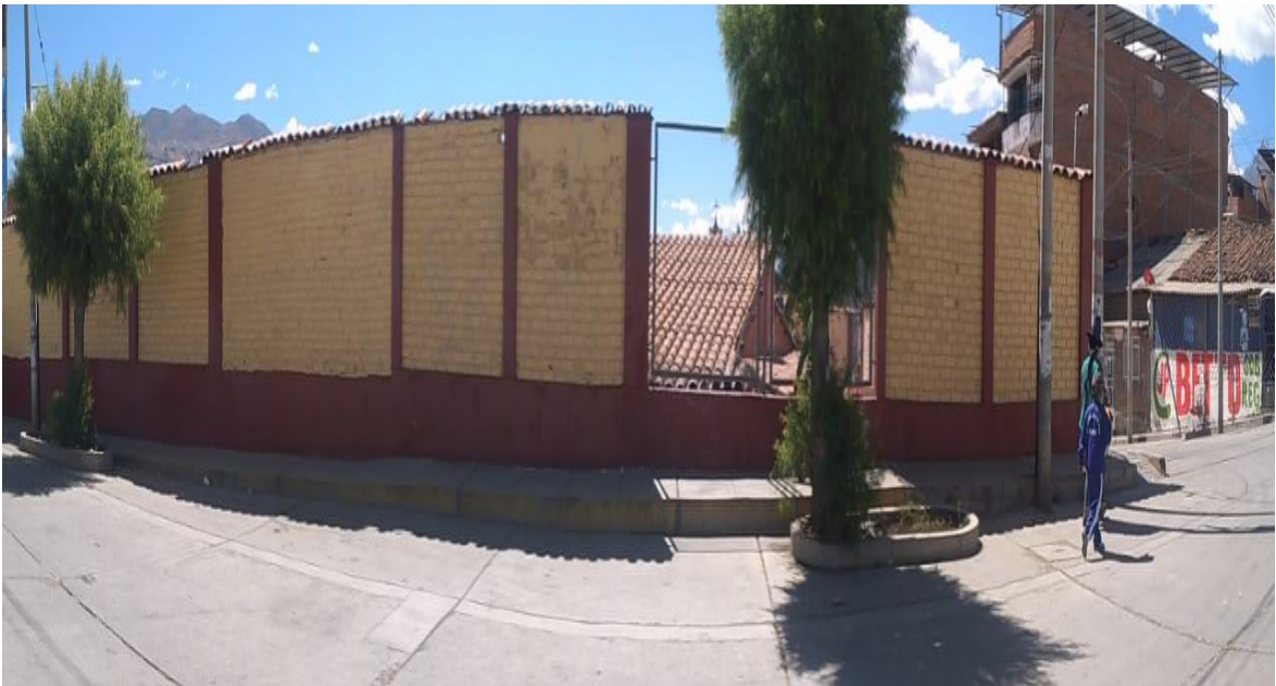
Fachada Lateral Izquierdo del CEDIF
