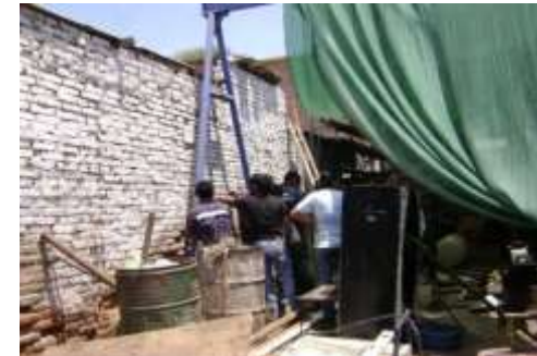
Figura 13: Área de Recepción
