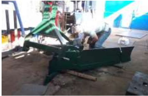
Figura 18: Área de Pintura
