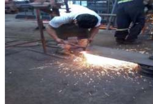
Figura 38: Área de Oxicorte , Personal ejecutando actividad de oxicorte manualmente.
