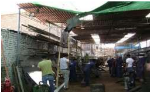
Figura 05: Personal de terceros realizando trabajos.
