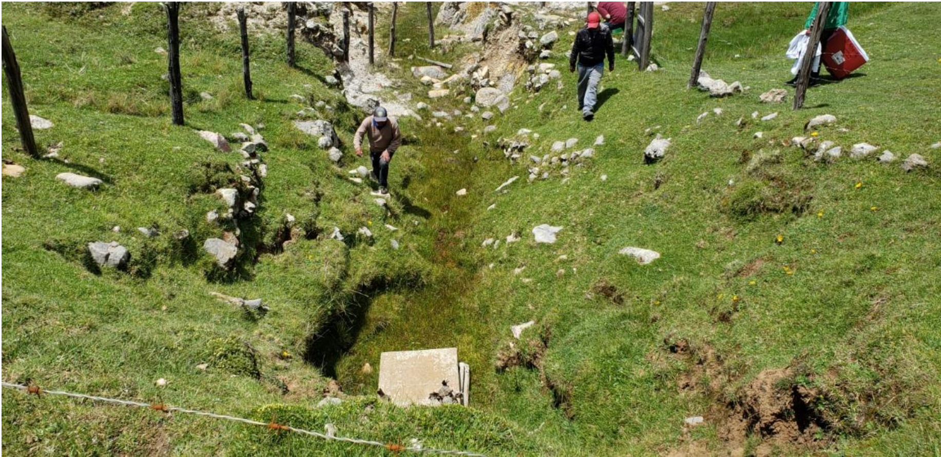
Captación Warmi (punto 3)
