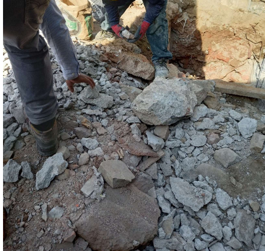
Figura 4. Demolición de la cisterna.
