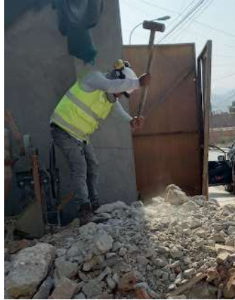
Figura 16: Primera Trituración del concreto reciclado.
