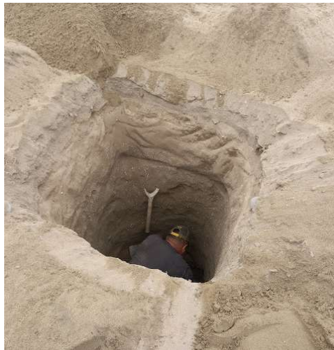
Figura 6: Realización de calicata.
