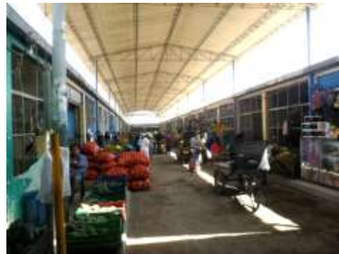
ZONA DE COMERCIO MAYORISTA EN LA CUAL SE APRECIA LA AFECTACION AL AREA DE CIRCULACION PEATONAL.
