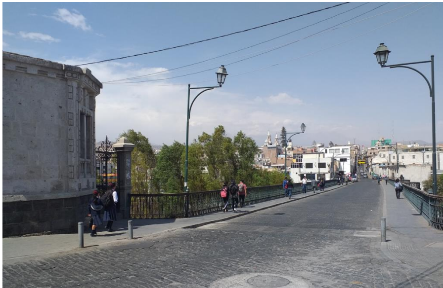
Foto Calle Beaterio Proyeccion a puente Bolognesi
