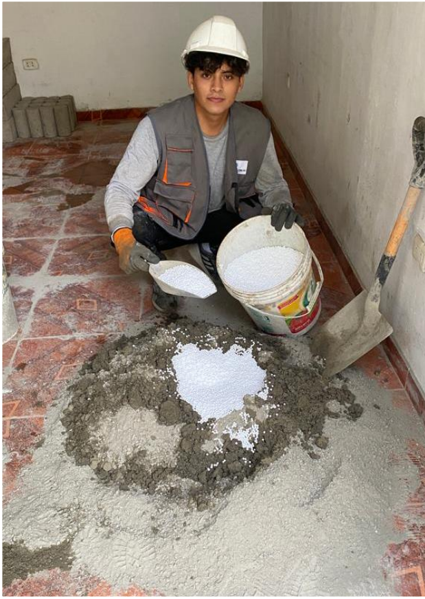
Foto 5: Incorporación de Perlas de Poliestireno
