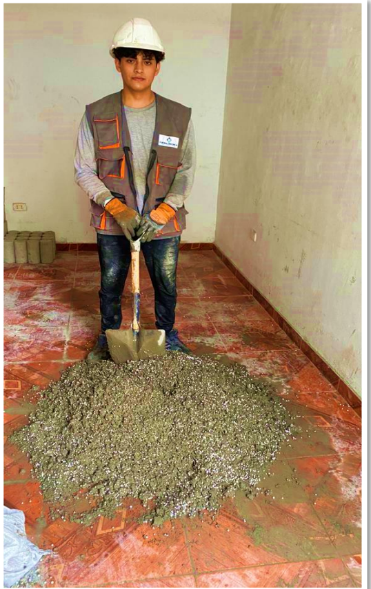
Foto 4: Mezcla manual con pala
