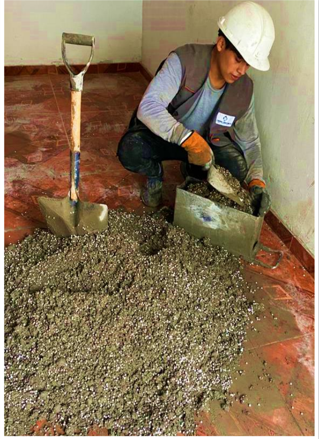
Foto 6: Vaciado al molde metálico
