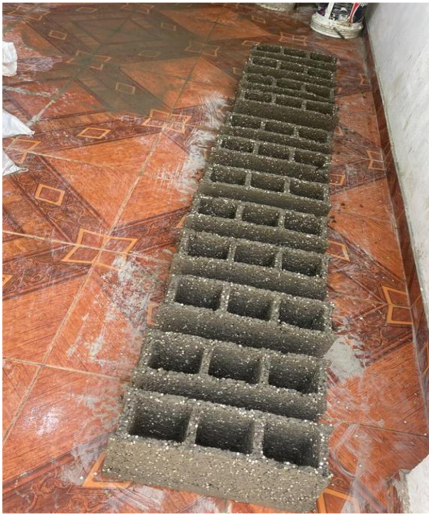
Foto 7: Bloques en proceso de secado
