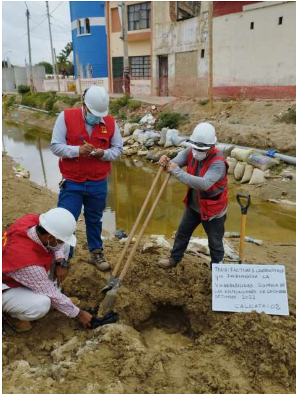
Figura 26: Tesistas recolectando las muestras en la calicata C2
