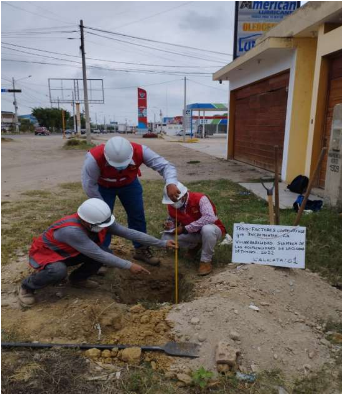
Figura 22: Tesistas comprobando la profundidad de la calicata C1
