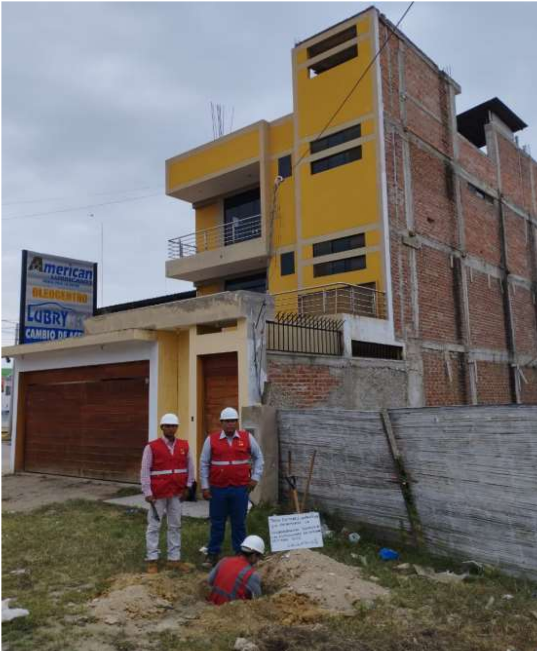
Figura 19: Calicata Número 1; corresponde a la edificación 16
