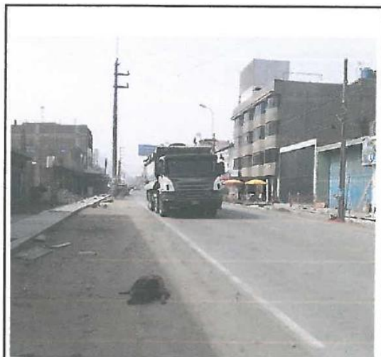
FIGURA N°24 :Se muestra el tránsito de vehículos pesados.
