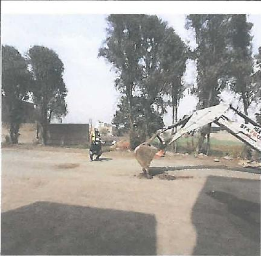
FIGURA N°49 :Ejecucion de la calicata N°4 ubicado entre la calle Saucos y la Calle Huancayo.
