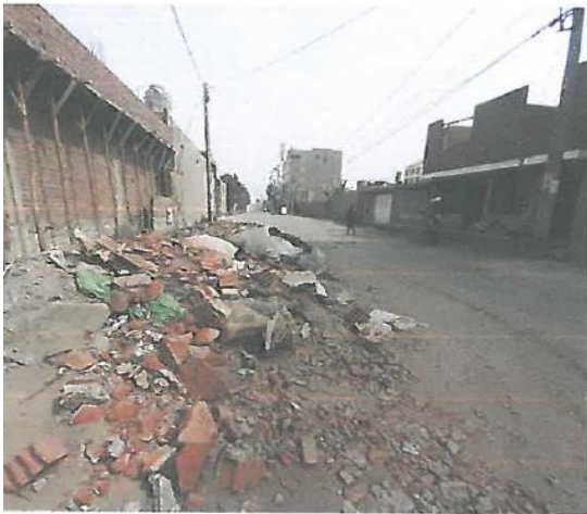
FIGURA N°17 :Entre las Calles El Portillo y Sauces se muestra el desmonte de materiales.
