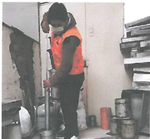
FIGURA N°47 :Se realizo el ensayo proctor para el material extraido de la calicata N°3
