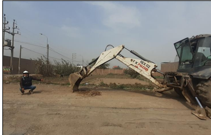
Figura 11. Excavaciones de calicatas
