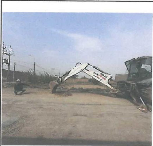
FIGURA N°25 : Ejecucion de la calicata N°1 ubicado entre la calle piura y la calle buenos aires.
