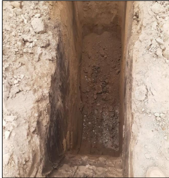
Figura 3. Calicata en la Calle Cajamarca
