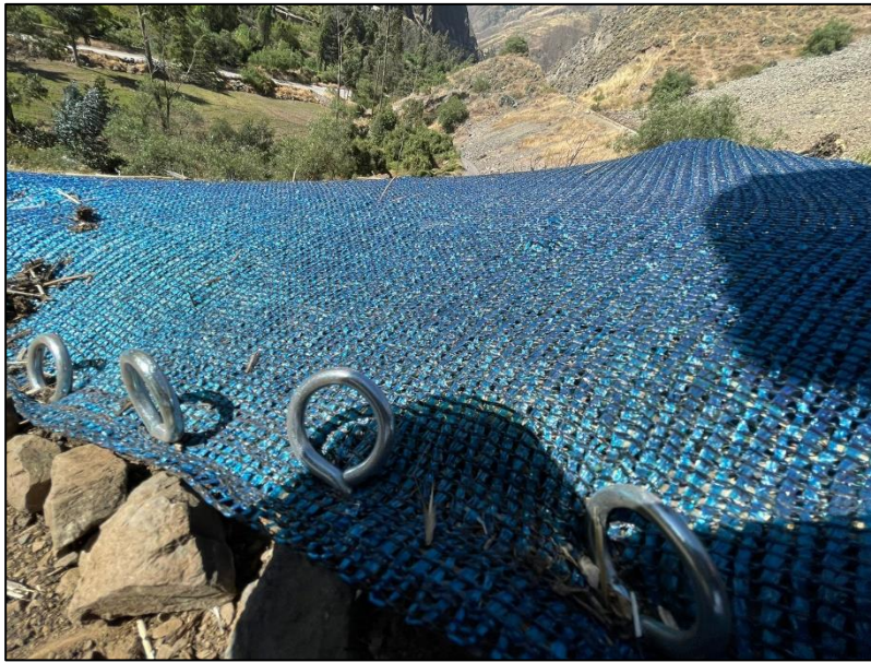
FOTOGRAFÍA 07. Tendido de geomembrana
