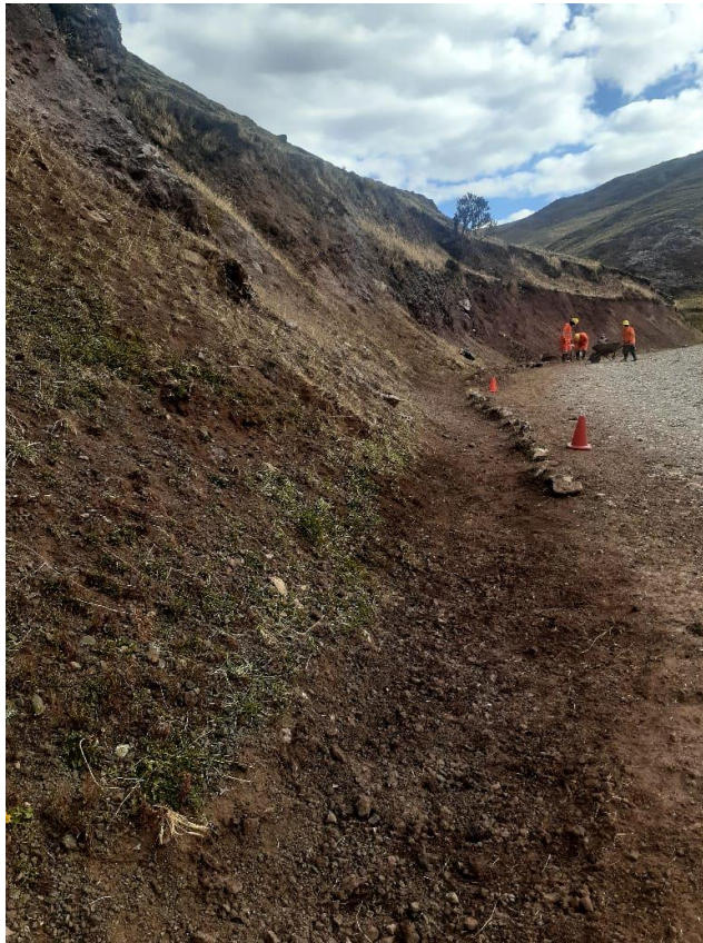
FOTOGRAFÍA 05. Evaluación de sección más crítica.
