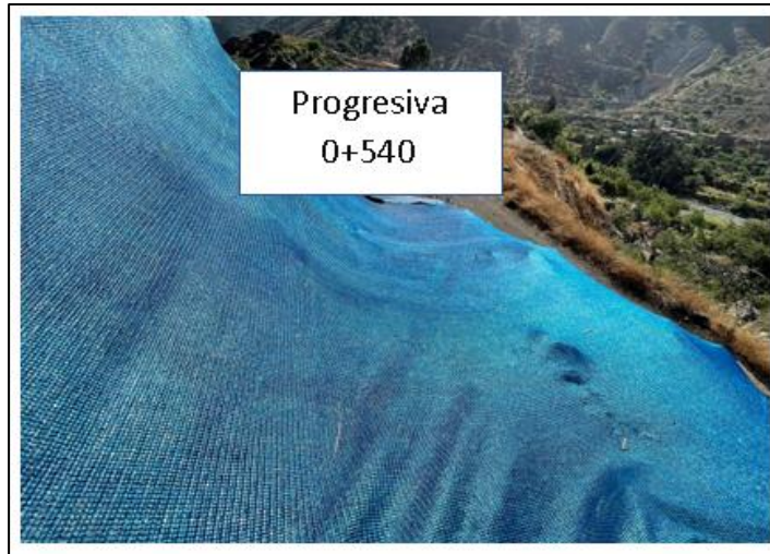
Figura 39: Geosintetico colocado
