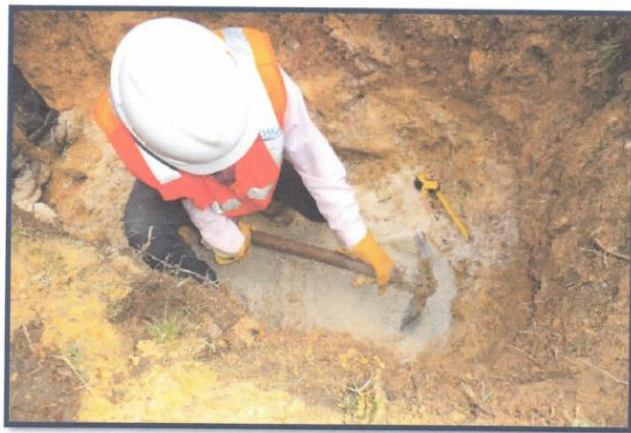
Figura 6: Verificación del tamaño de la calicata
