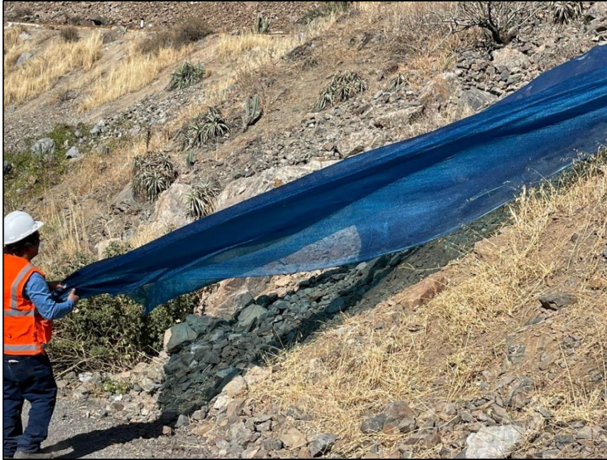
Figura 37: Colocación de Geomalla
