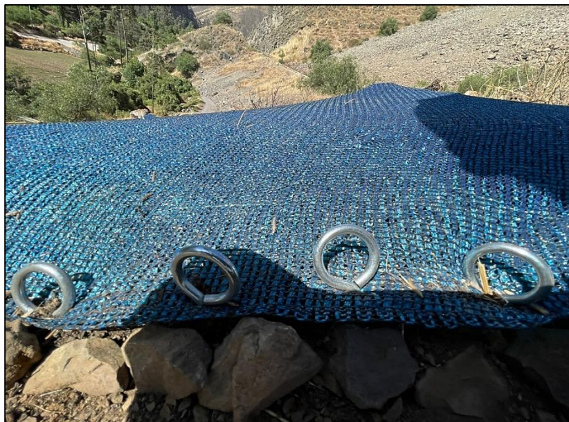
Figura 38: Colocación de Geosintetico sobre el stipa ichu
