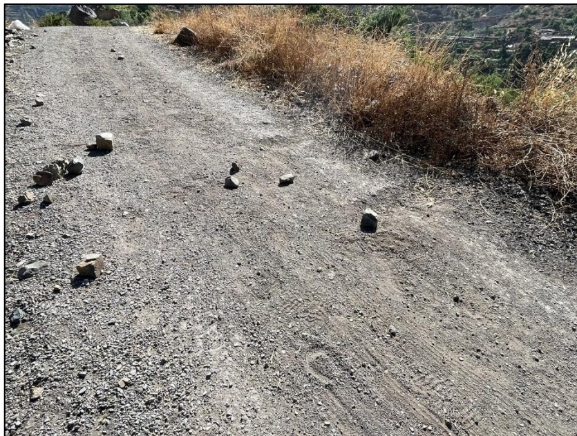
FOTOGRAFÍA 06. Presencia de piedras en la carretera.
