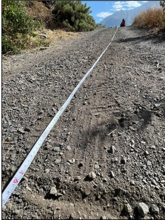
FOTOGRAFÍA 01. Tramo de la carretera 0+540 hasta 0+660
