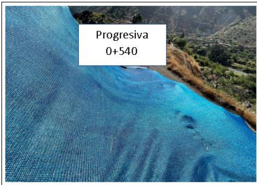
FOTOGRAFÍA 08. Tendido de geomembrana
