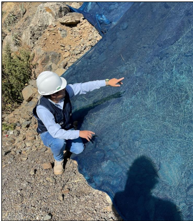
FOTOGRAFÍA 09. Tendido de geomembrana
