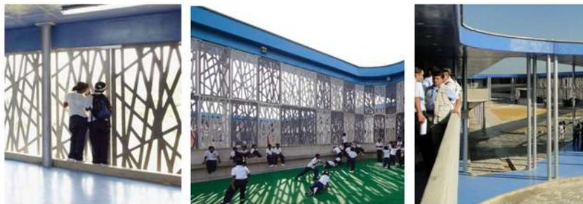
Membrana en fachada que permite la ventilación e iluminación natural aprovechando los recursos y minimizando el uso de luz artificial.
