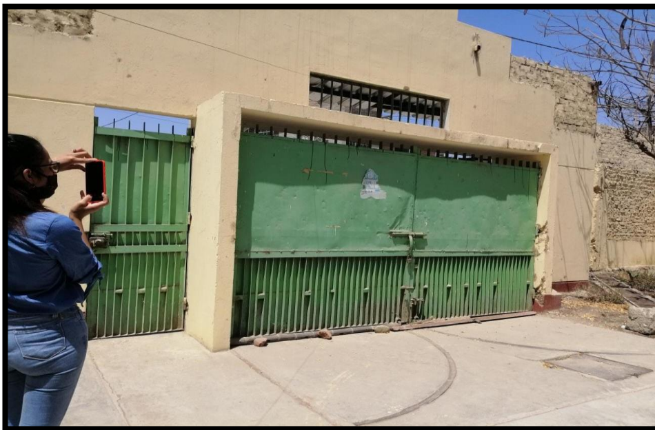
Fig. 3: Los portones metálicos en regular estado.
