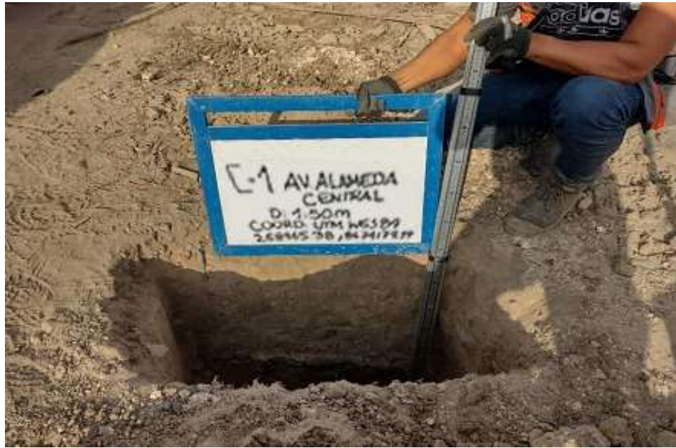
Figura 26. Calicata C-01, Ubicada en la Avenida Alameda Central con la Avenida F
