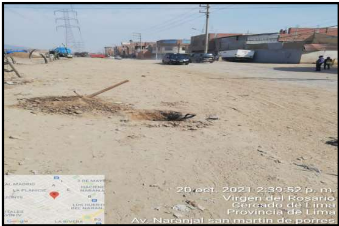
fotografía 2. Excavación de calicatas
