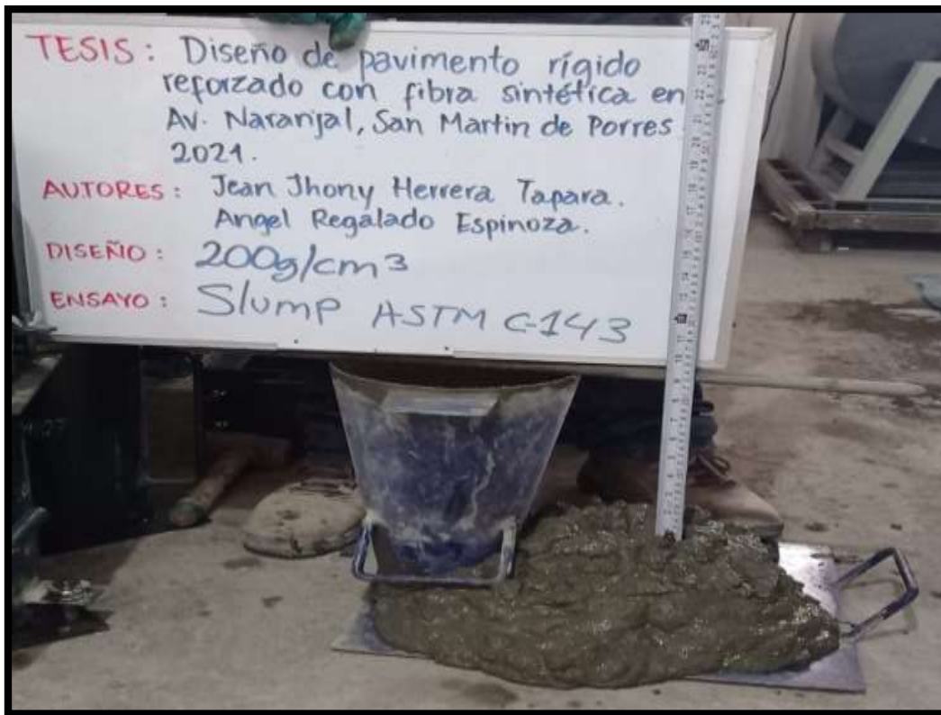
fotografía 14. Realizando el control slump del concreto con fibra
