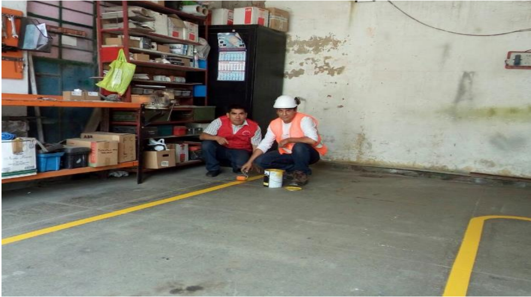
Gráfico 25: Demarcación de áreas, recuperada zona de libre tránsito Delimitación del área del trabajo demarcando los pisos en prevención de riesgos de accidentes
